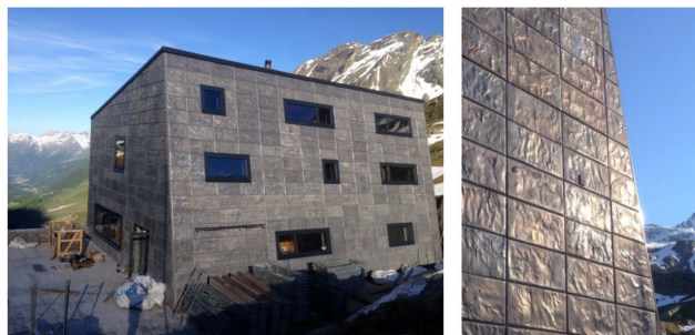
Slika 9.8: Fasada cerkve, prekrita s ploščami iz kovinske pene, in fasada gorske kočice, prekrita s kompozitnimi ploščami s sredico iz aluminijeve pene [63]
