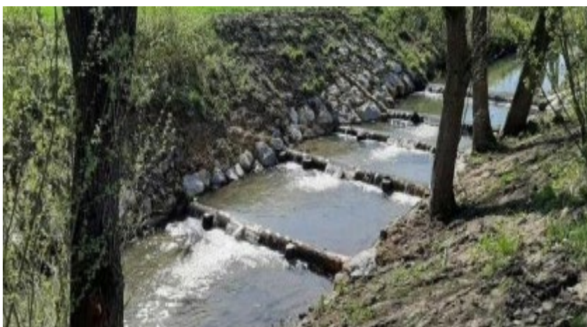
Slika 3: Uporaba lesenih hlovdov je pogost ekoremediacijski ukrep, ki je cenovno primeren in funkcijsko učinkovit.
