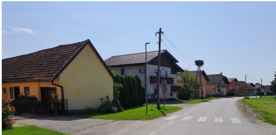
Slika 6: Del naselja Stražgonjca – nove stanovanjske hiše so nadomestile nekdanje kmečke hiše, pri čemer se je ohranil položaj kmečke hiše, ne pa tudi oblika
