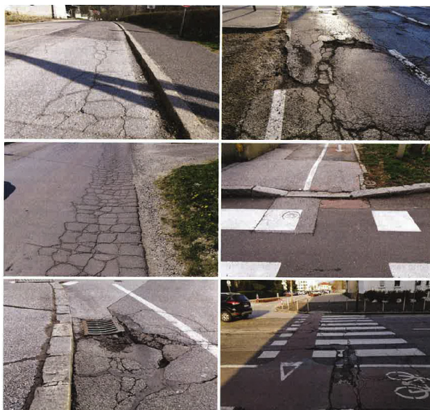
Slika 4: Primeri poškodb in drugih nepravilnosti, ki otežujejo vožnjo e-skirojev
