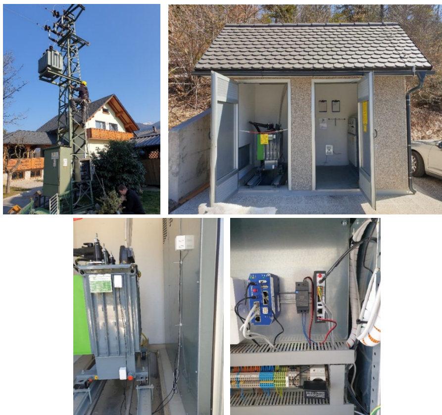
Slika 10: Namestitev merilne tehnike ob transformatorjih.
