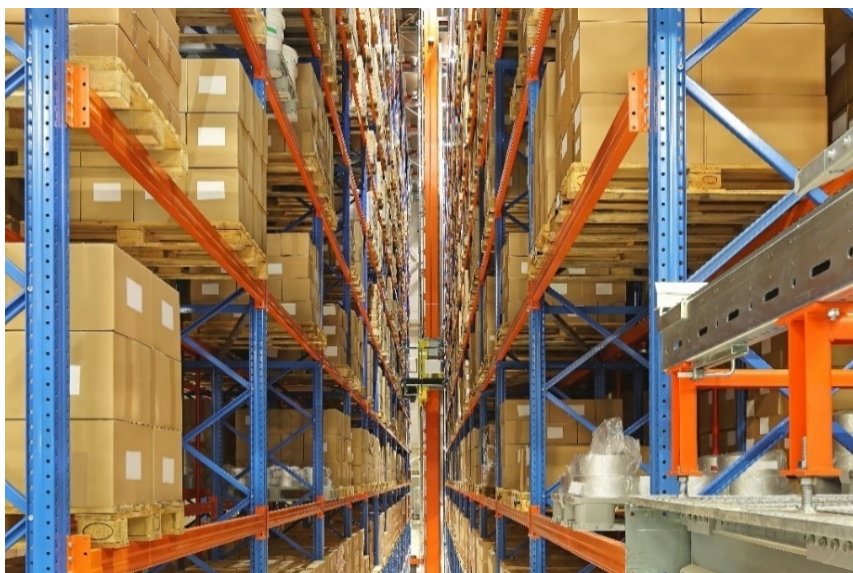
Slika 37: Avtomatizirano paletno regalno skladišče z regalnim dvigalom
