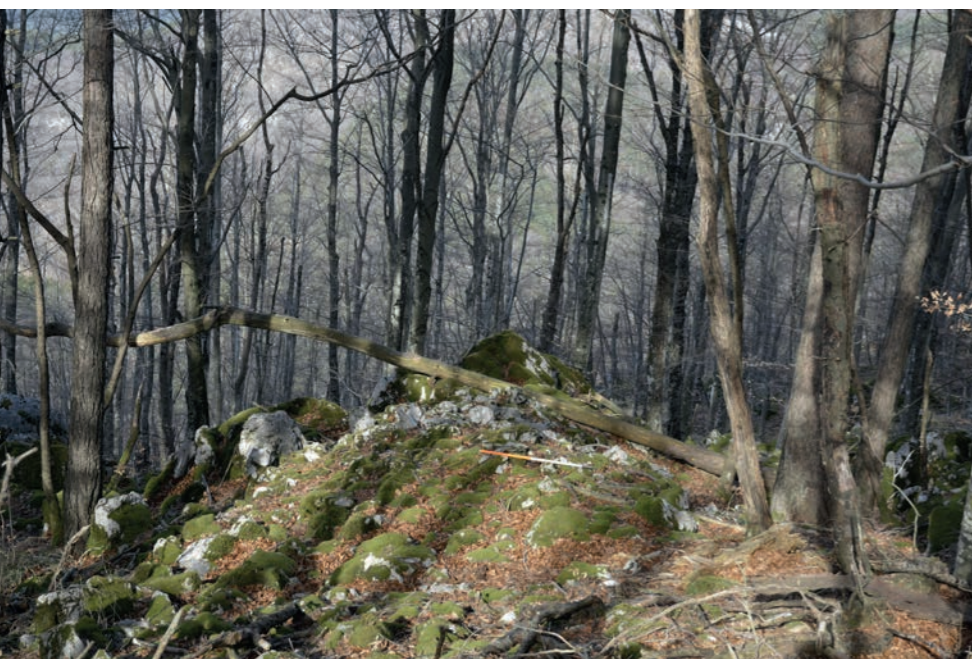
Sl. 14. Gradišče Kuk: detajl ruševine prvega obzidja (foto: N. Kuzmanović)
