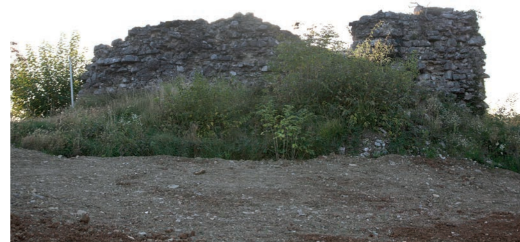
SI. 7. Pogled na ostanke utrdbe – stolpa od vzhoda (foto: M. Prešeren, 2019)
