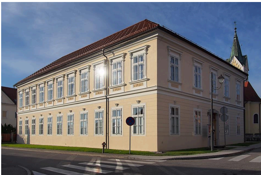
Slika 7: Slomškov dom danes, po temeljiti obnovi
