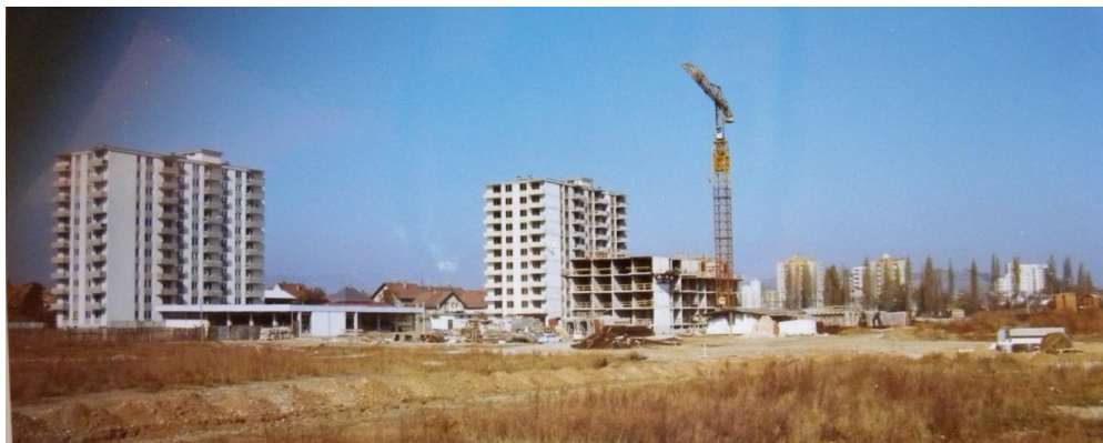
Slika 135: Med gradnjo soseske, leta 1975.
