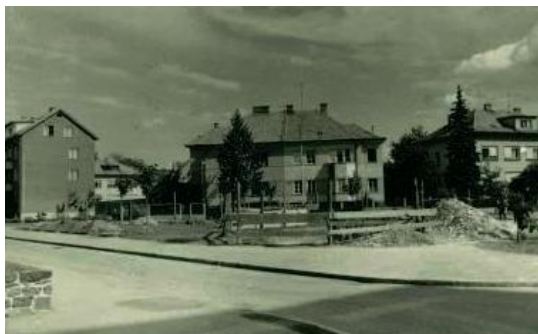
Slika 71: Zaustavitev gradnje bencinske črpalke
