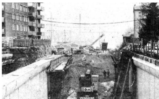
Slika 85: Ob izgradnji vkopanega tunela v soseski
