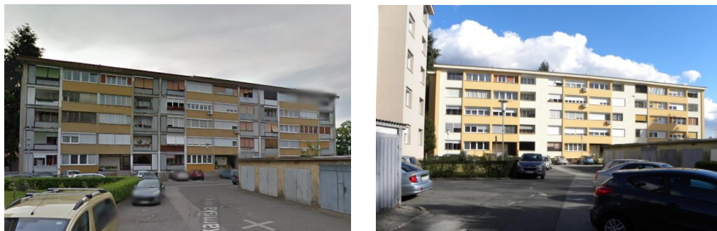
Slika 293: Lamelni blok Majeričeva ul. 2–6 pred energetsko sanacijo in po njej
