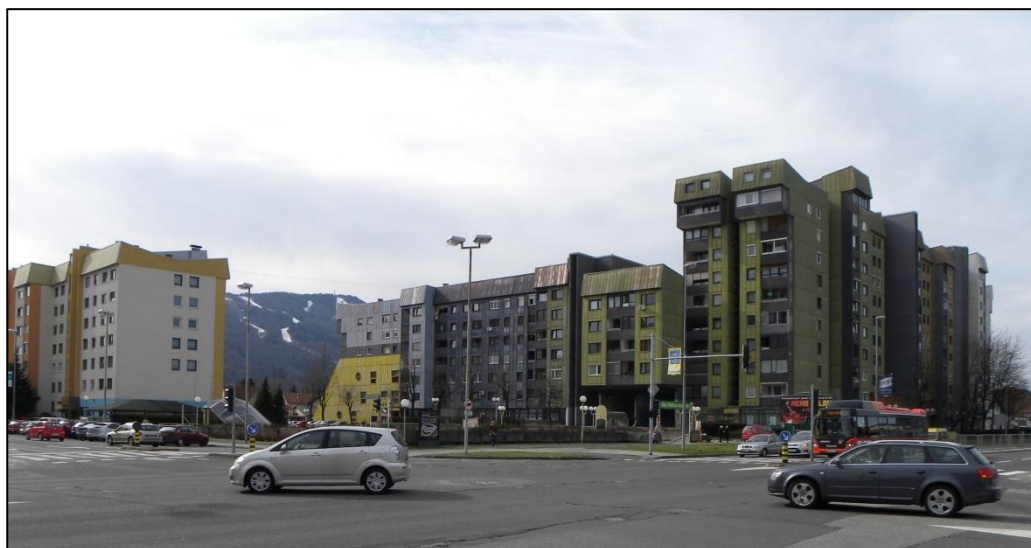
Slika 171: Stanovanjski bloki so ob križišču dveh primarnih prometnic.
