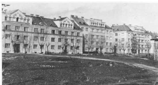
Slika 7: Stanovanjski bloki v Smetanovi ulici
