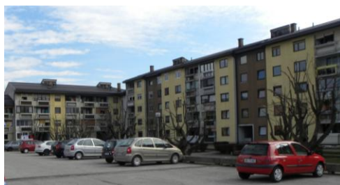
Slika 156: Verižno-terasni blok ob Ulici Veljka Vlahovića
