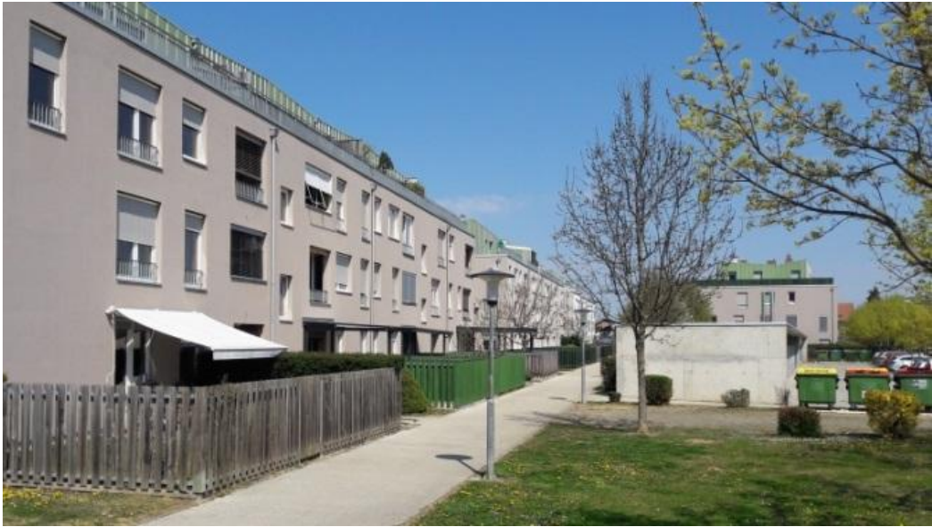
Slika 217: Osrednja komunikacijska pot v soseski ob Kamenškovi ulici
