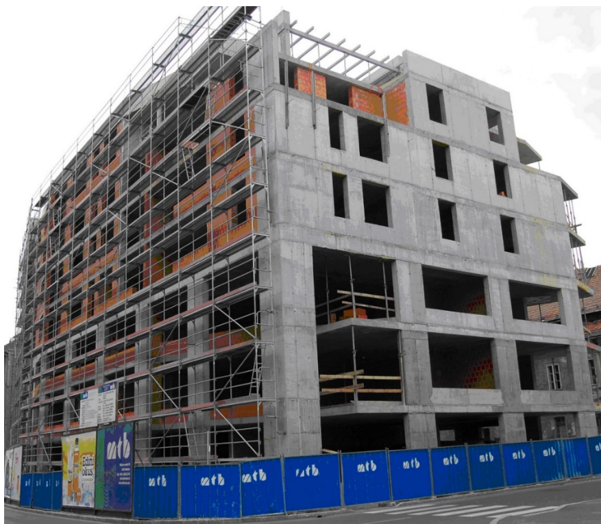
Slika 4.2: Očitno zmanjšanje vertikalne togosti po višini v vzdolžni smeri ter povečanje togosti v prečni (stanje 27. 4. 2010 do danes)
